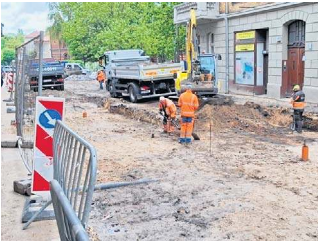
Prace na ul. Kosynierów Gdyńskich prowadzi Prasbet
