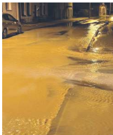
Awaria wodociągu na ul. Ogrodowej w Chełmie
