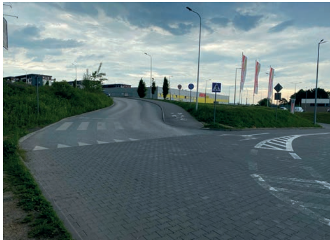
Skrzyżowanie ul. Krasowej z wyjazdem ze sklepów
