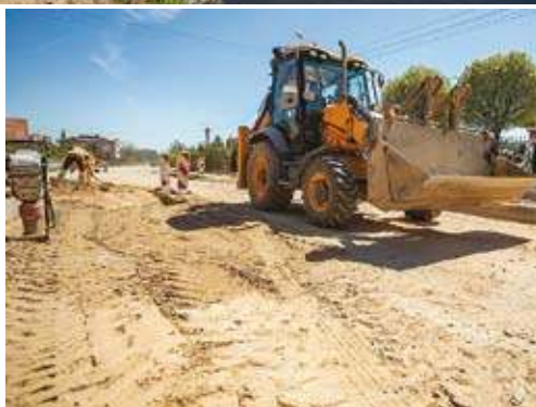
Budowa ulicy Szkolnej
