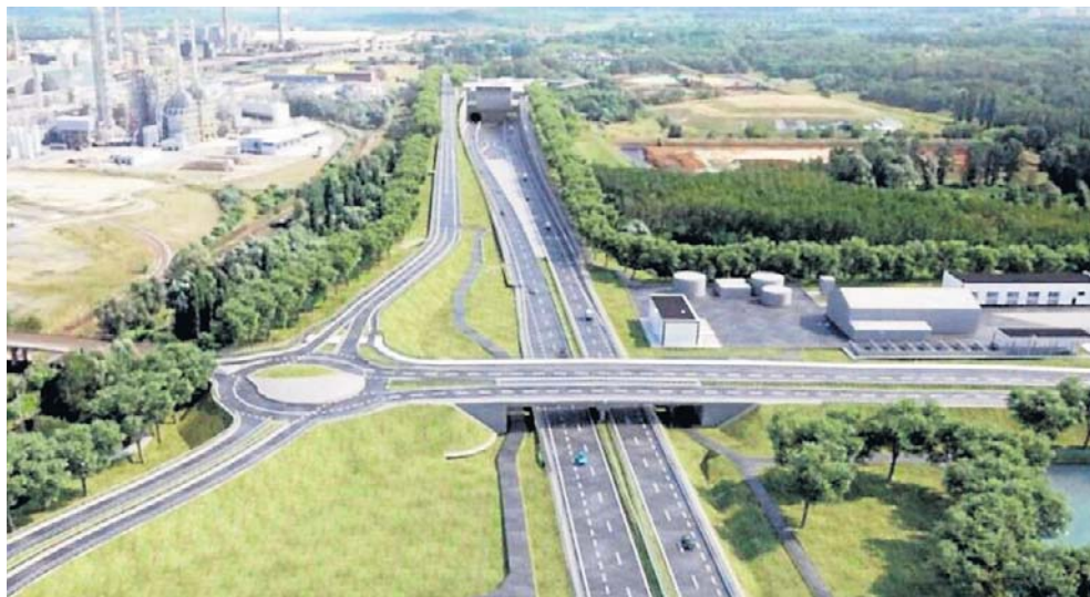
Wzajem Policie na powstającej Zachodniej Obwodnicy Szczecina z wjazdem do tunelu pod Odrą
