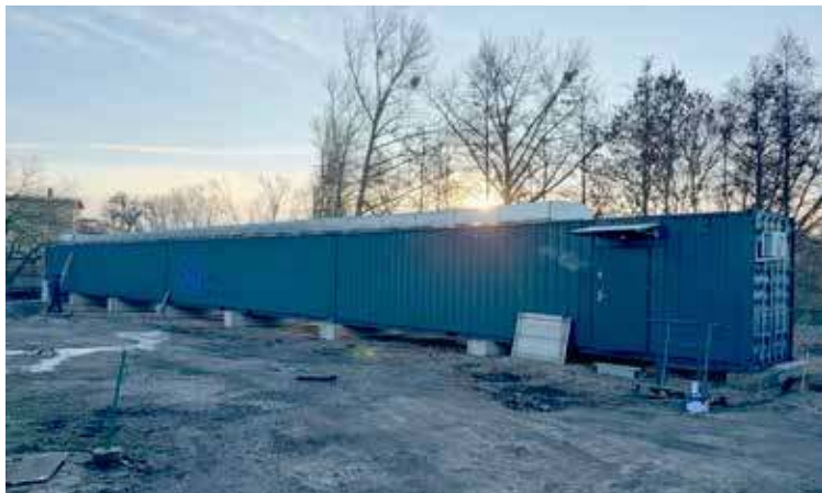
Obiekt przy ul. Zamkowej w budowie
