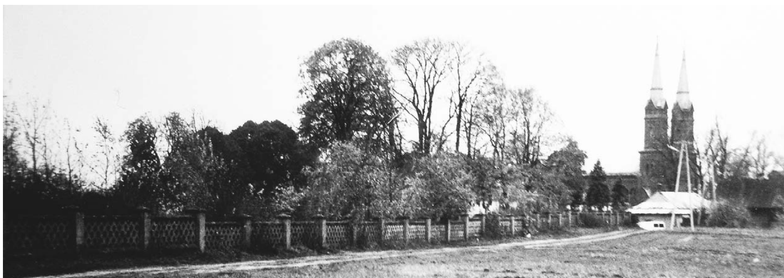
Widok ogólny Wieczfnia, ok. 1985 r. Widoczny mur cmentarza, OSP oraz kościół
