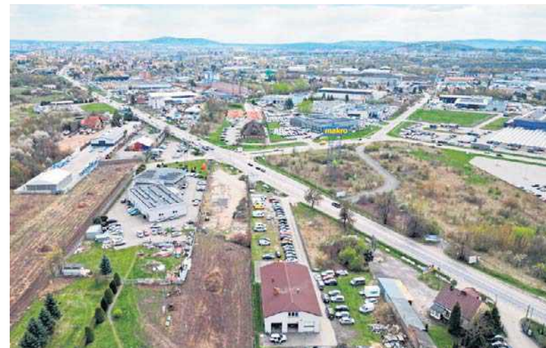
Ulica Łódzka i odchodzące od niej ulice Transportowców i Kongresowa - na skrzyżowaniu pojawi się tymczasowe rondo.
