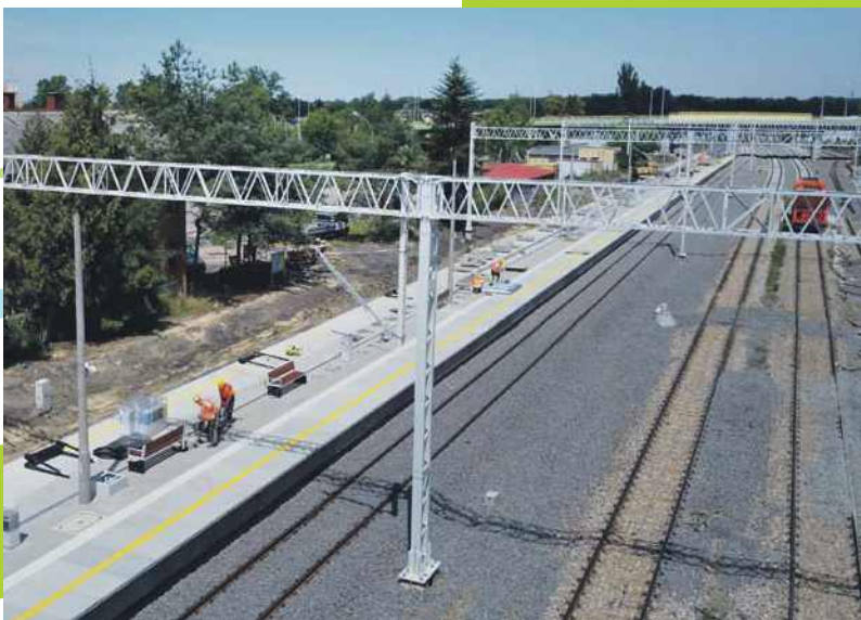
Prace na stacji kolejowej Tarnobrzeg
