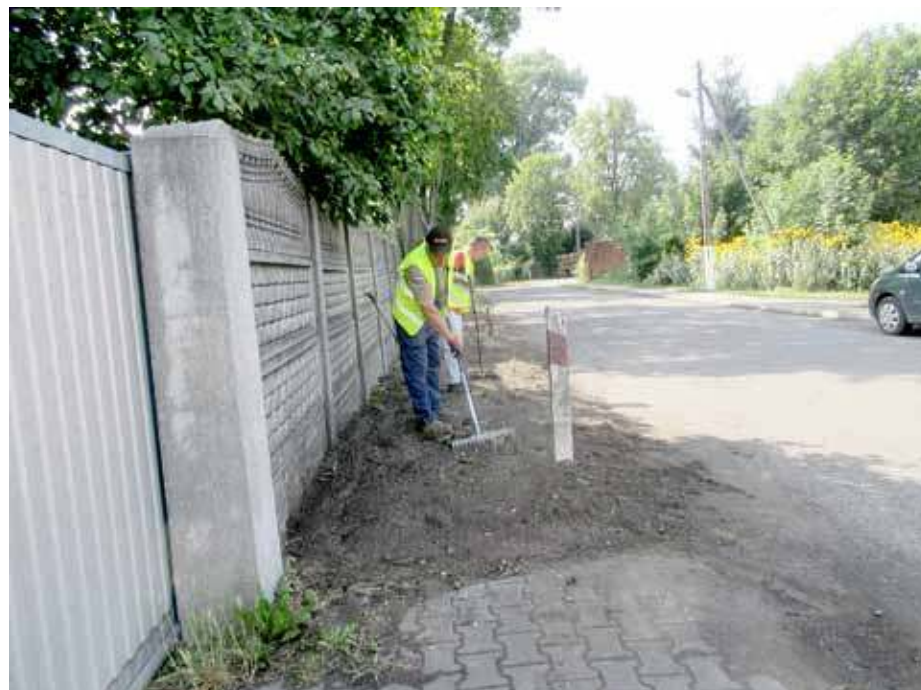
Mniszki - mieszkańcy narzekają, że firma układająca światłowód nie odtwarza trawnika, który rozkopała
