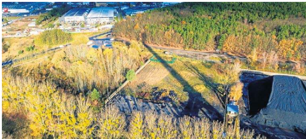
Próbnny odwiert będzie na działce elektrociepłowni Dąbska na prawobrzeżu Szczecina
