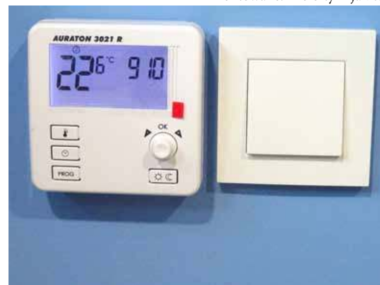
Regulacja ciepłoty podłogi w szatni zawodników.JPG
