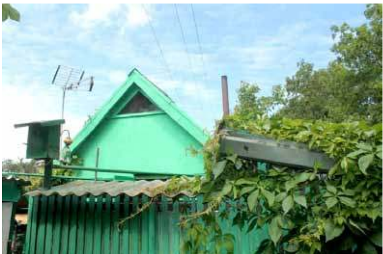
Nad działką przechodzi linia napowietrzna średniego napięcia
