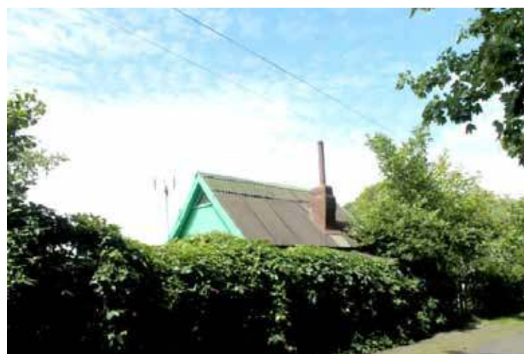
Nad działką przechodzi linia napowietrzna średniego napięcia
