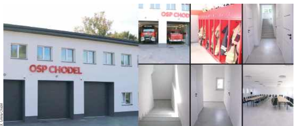
Od podstawowego remontu do kompleksowej modernizacji - remiza OSP KSRG Chodel została dostosowana do potrzeb strażaków i KGW „Chodelanki”
