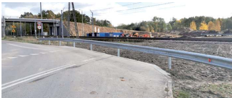
Obecnie w miejscu przejazdu zerwany został asfalt, a zamiast rogatek pojawiła się barierka
