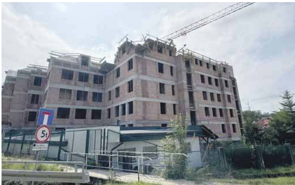
Ekipy budowlane wznoszą konstrukcję dachu.
