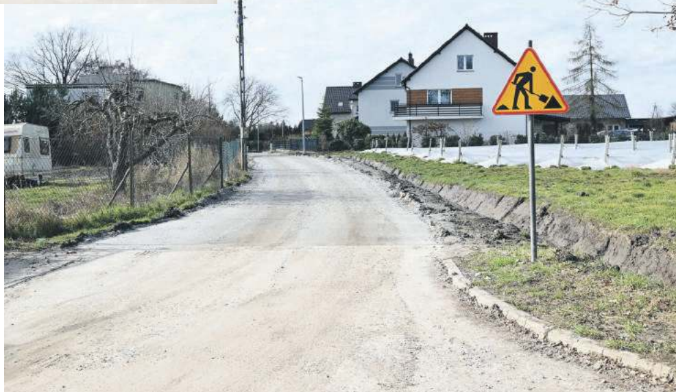
W Strzeszowie rozpoczęła się przebudowa ul. Młynarskiej
