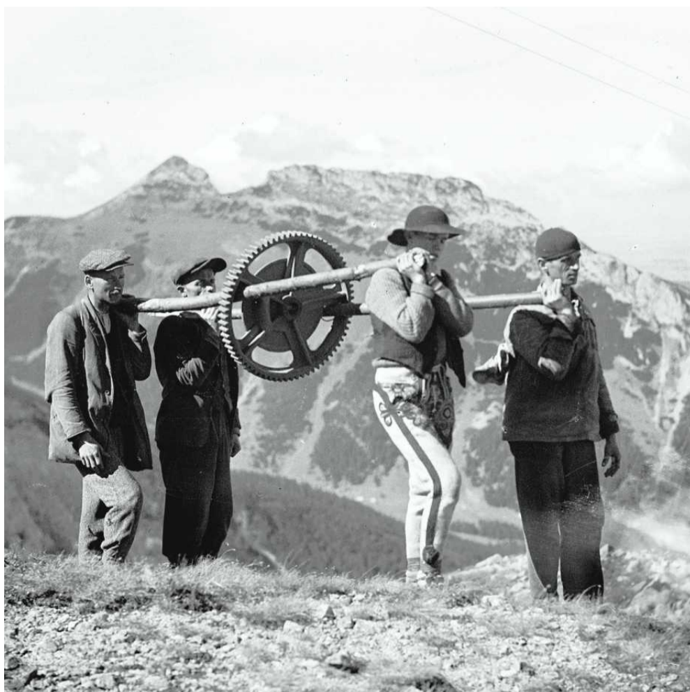
▲ Robotnicy transportują koło zębate wyciągarki kolejki transportowej, którą dostarczano materiały budowlane na szczyt Kasprowego Wierchu, 1935 rok
