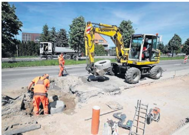
Na ulicy Warszawskiej w Kielcach rozpoczęły się prace przy wymianie nawierzchni
