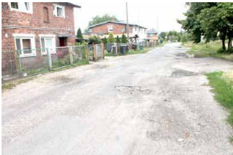
W tej chwili po obu stronach drogi pobocza są nieutwardzone, a światła dają latarnie starego typu
