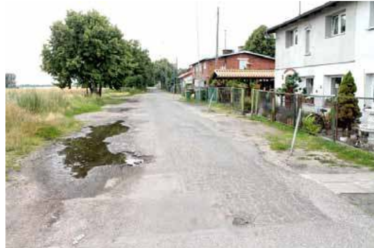
Nawierzchnia drogi zostanie wyremontowana w ramach Polskiego Ładu
