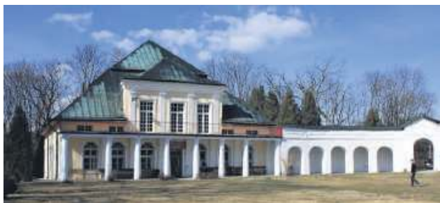
W planach jest rewitalizacja istniejących obiektów sanatoryjnych oraz budowa nowych.
