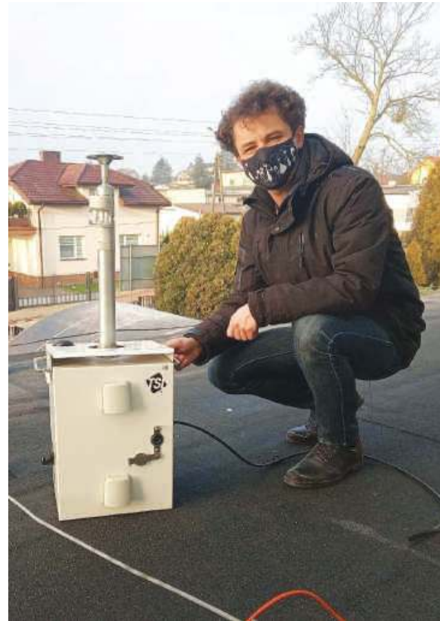
Montaż czujnika na dachu szkoły.
