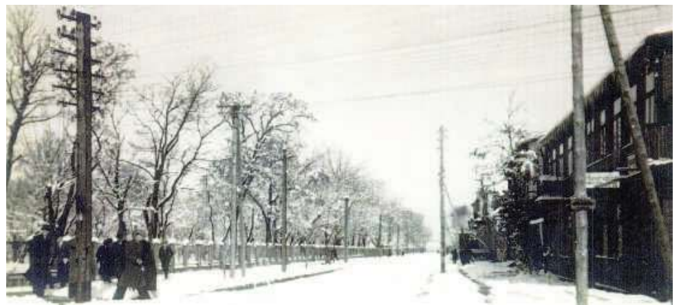
Ulica Marcina Lutra pomiędzy 1940 a 1942 r.
