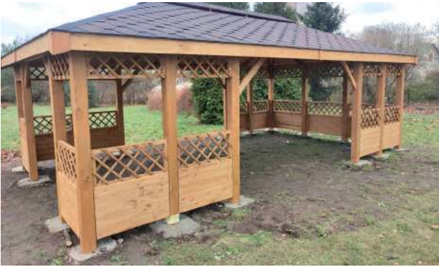
Otoczenie szkoły wypiękniało dzięki nowym instalacjom z drewna
