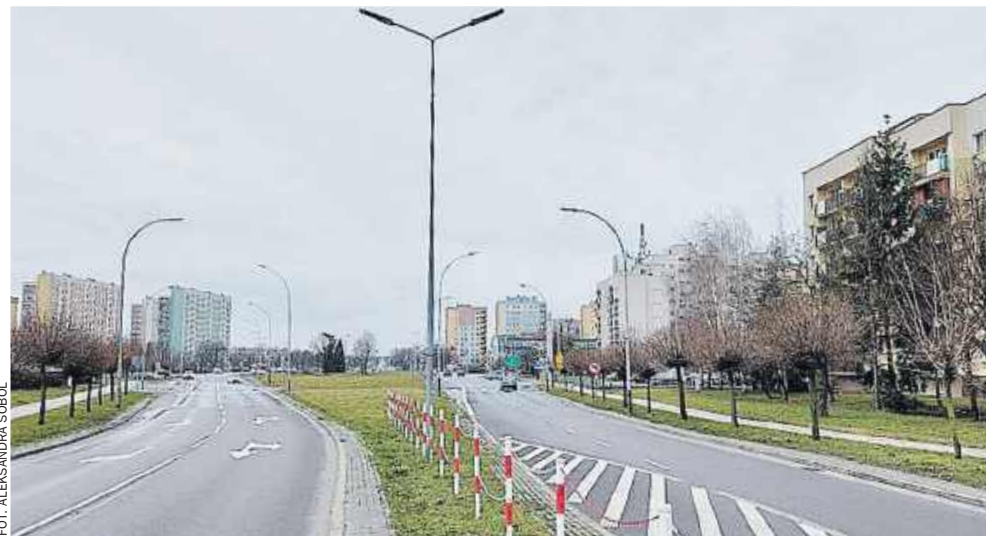
Ponad 200-metrowy odcinek ulicy KEN biegnący od ulicy Poniatowskiego do skrzyżowania z Al. Jana Pawła II w Stalowej Woli doczeka się przebudowy
