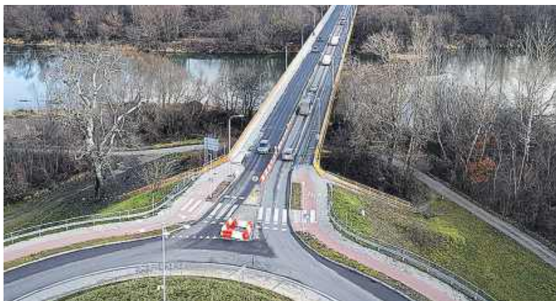
Na most na Sanie wraca ruch wahadłowy
