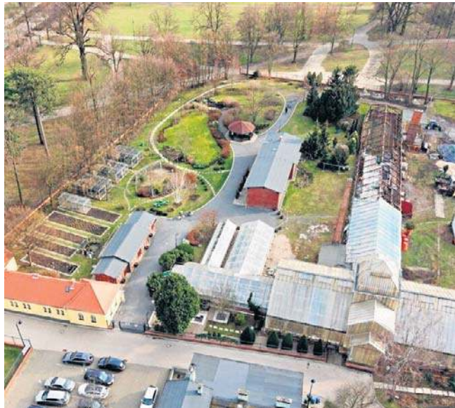
Całość prac w Palmiarni ma zostać zakończona w październiku 2026 roku
