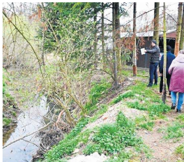
Wątok i Wątoczek w wielu miejscach przepływają blisko posesji, a obsuwające się brzegi zagrażają budynkom
