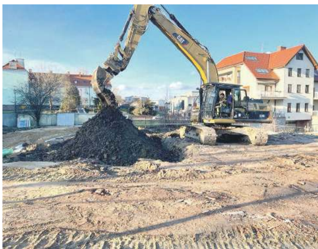
Została jeszcze część starych fundamentów. Stan surowy powinien stanąć do 10 lipca tego roku
