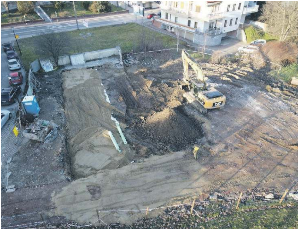
30 grudnia 2022, tak wyglądał plac budowy Biblioteki Miejskiej...
