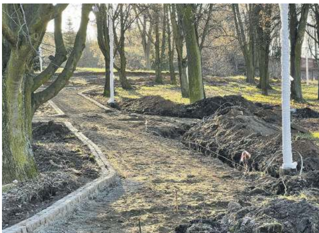
Aleja jest dopiero budowana, są rowy i nie ma obrzeży
