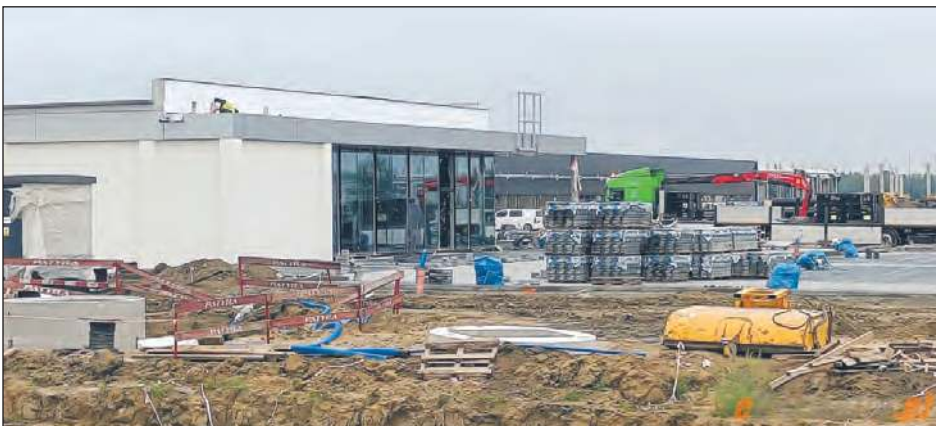
PKB Inwest Budowa realizuje nowy park handlowo-usługowy przy ul. Trakt Lwowski, na działce o powierzchni około 3,6 hektara
