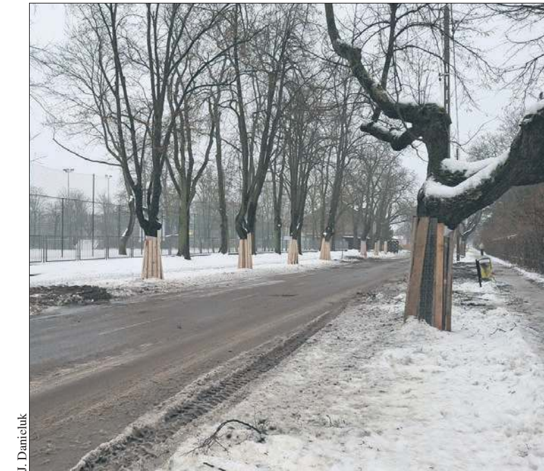
Przy przebudowie ul. Wyszogrodzkiej zostanie wyciętych kilkadziesiąt drzew. Te, które zostają, zostały zabezpieczone przed uszkodzeniami
