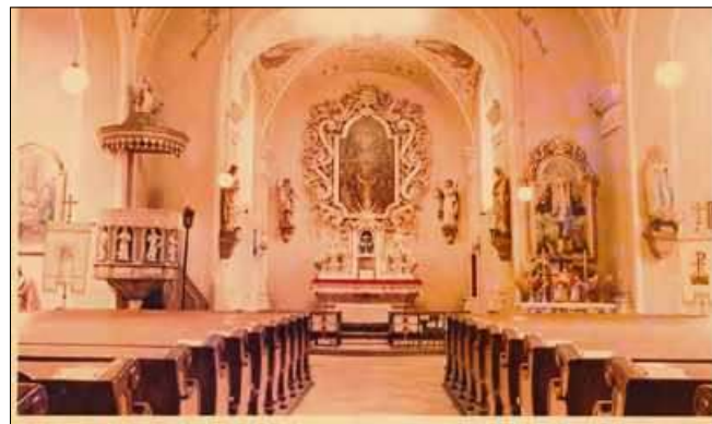
Zdjęcie wnętrza kościoła wykonane w 1967 r.
