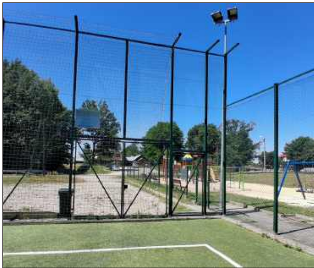
Boisko natomiast ma nowe ogrodzenie.
