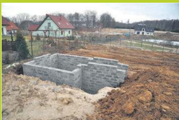
Ziemianka została wybudowana na głębokości 1,5 metra.
