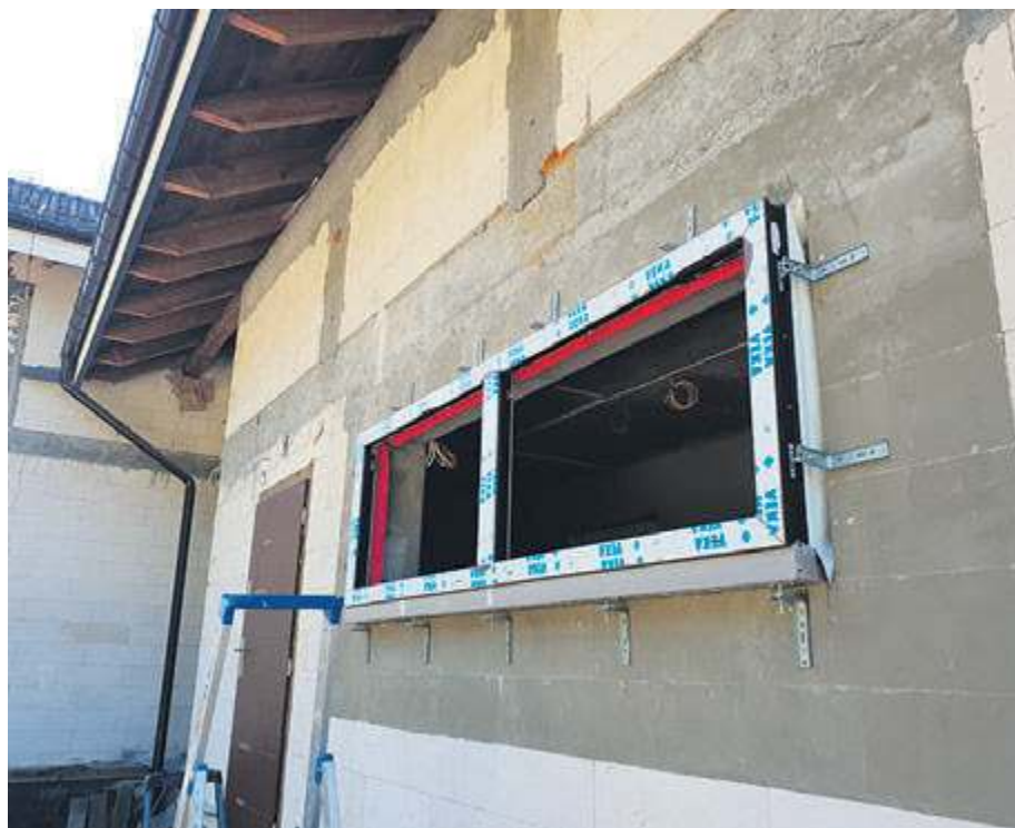
W modzie są obecnie duże przeszklenia i duże rozsuwane okna tarasowe, takie jak na zdjęciu. Obecnie stosuje się montaż okien poprzez ich wysunięcie poza lico muru.
