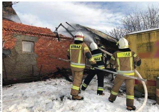
Rzecznicy oceniają, czy uda się odbudować dom, czy trzeba zburzyć resztę konstrukcji i zbudować wszystko na nowo
