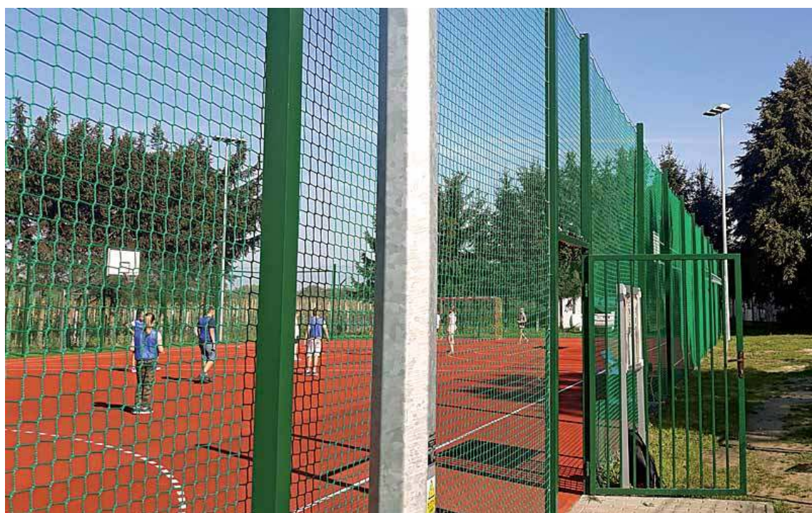
Boisko wielofunkcyjne wybudowano w miejscowości Glinki, gm. Karczew (fot. arch. UMWM)
