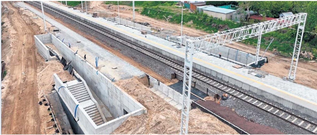
Nowe przystanki kolejowe na trasie Słupsk - Lębork powstają w Siemianicach (nazdjęciu), Runowie i Łebieniu
