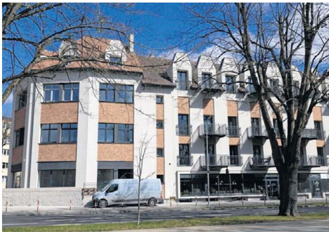
Budynek przy ul. Władysława Jagiełły - jedno z potencjalnych miejsc ukrycia w Słupsku
