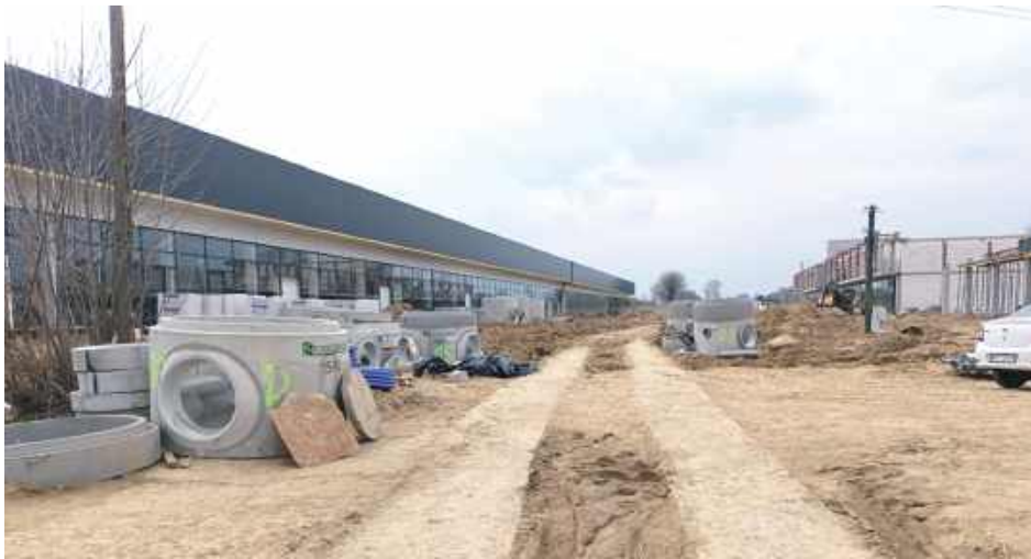
Prace nad budową nowej galerii nie ustają. Jak wiemy, w tym miejscu ma powstać 400 miejsc parkingowych.
