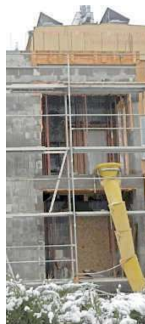
Pacjenci niepełnosprawni nie będą już musieli odbywać długiej wycieczki do windy w budynku szpitala. Windą przy wejściu głównym dostaną się zarówno z zewnątrz, jak i będą mogli poruszać się pomiędzy piętrami
