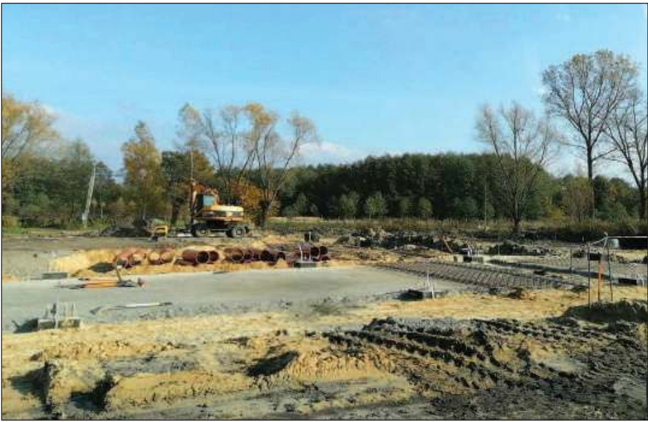
Prace przy pierwszej części inwestycji już się rozpoczęły. Wybudowany zostanie parking samochodowy na ponad sto aut
