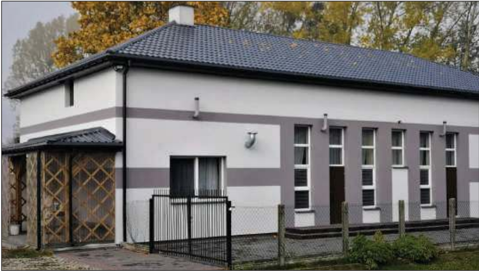
Nowa elewacja świetlicy sprawiła, że budynek stał się wizytówką wsi
