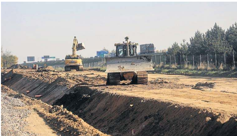
Prace przy budowie drogi lotniskowej przebiegają bardzo sprawnie
