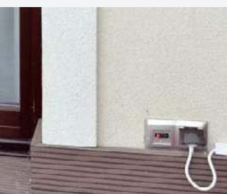
➤ Odporne na czynniki atmosferyczne gniazda na tarasie.
