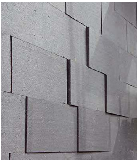
🔧 Wystawienie płyt szarego styropianu na bezpośrednie działanie słońca może skończyć się ich deformacją i oderwaniem od podłoża. SWISSPOR
