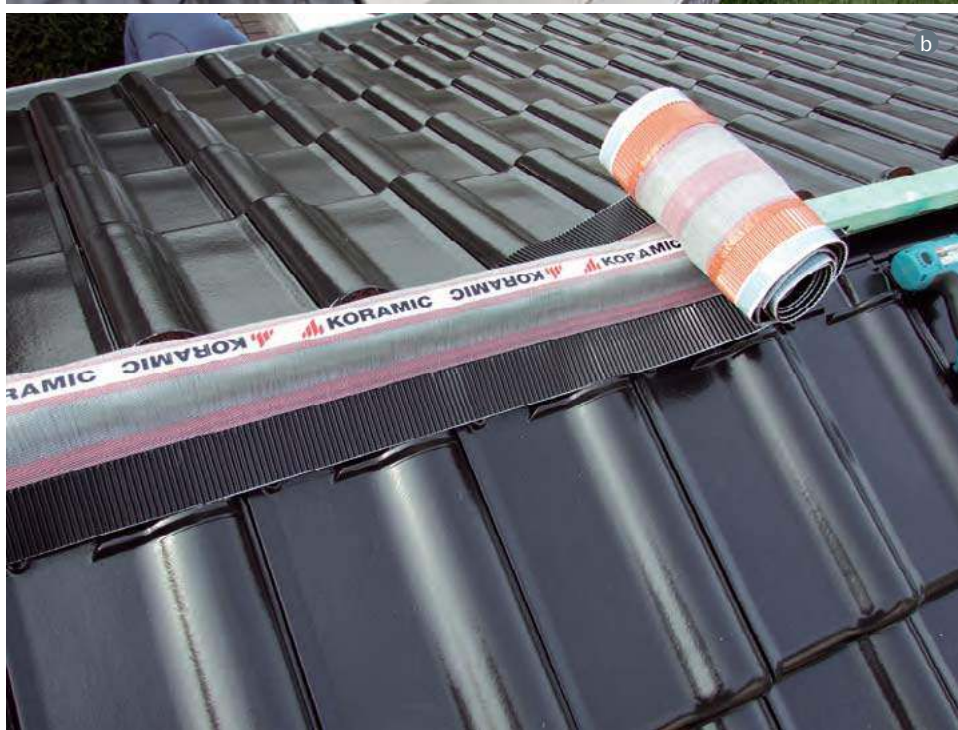
🔧 🛠️ Rozmaite akcesoria dachowe: gotowe obróbki blacharskie – wiatrownica, gąsior (a BUDMAT), wentylacyjna taśma kalenicowa (b WIENERBERGER), płotek przeciwśnieżny (c CREATON POLSKA).
