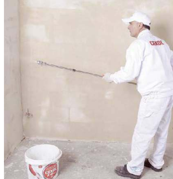
Maszynowa aplikacja tynków i gładzi znacznie przyspiesza prace. CEDAT
