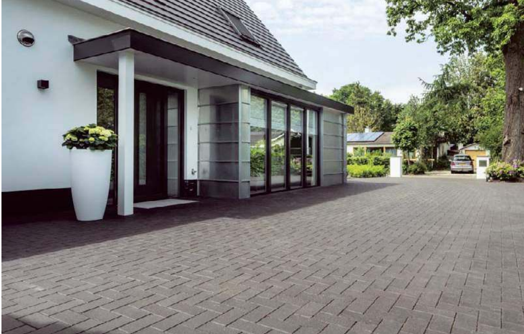
📌 Bruk klinkierowy jest naturalnym materiałem wypalonym z gliny i piasku. Jest znacznie trwalszy niż betonowy. Oferowany jest w wielu kolorach. VANDERSANDEN
