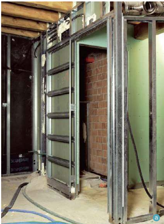
☞ Kaseta drzwi chowanych w ścianie przeznaczona do wykończenia płytami gipsowo-kartonowymi (a) oraz model do otynkowania (b). ECLISSE
