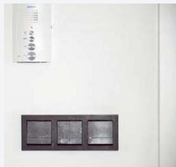
Wielomodułowy łącznik klawiszowy z diodami LED oraz osprzęt w instalacji domofonowej umieszczono przy głównym wejściu do budynku.
