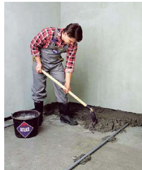
🔗 Wykonywanie jastrychu cementowego na podłożu na gruncie. ATLAS
