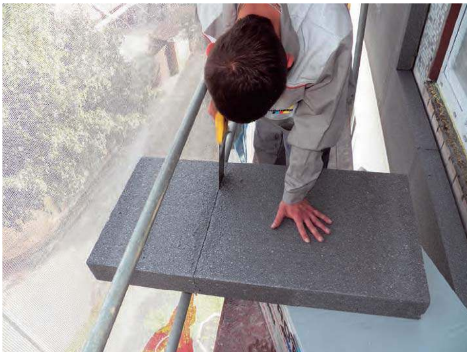
🔧 Staranne ostonięcie elewacji siatką rozpiętą na rusztowaniach skutecznie zabezpiecza styropian przed działaniem słońca. AUSTROTHERM
