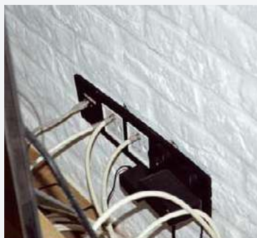
W pokoju telewizyjnym i w sypialniach właściciele założyli listwy z gniazdami wtykowymi i teletechnicznymi.
