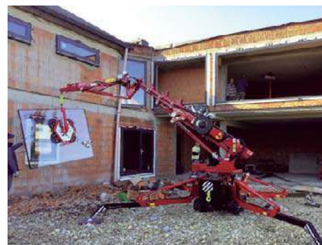
Montaż dużych i ciężkich przeszkleń na ogół wymaga użycia dźwigu ze specjalną przyssawką do szkła. VETREX
