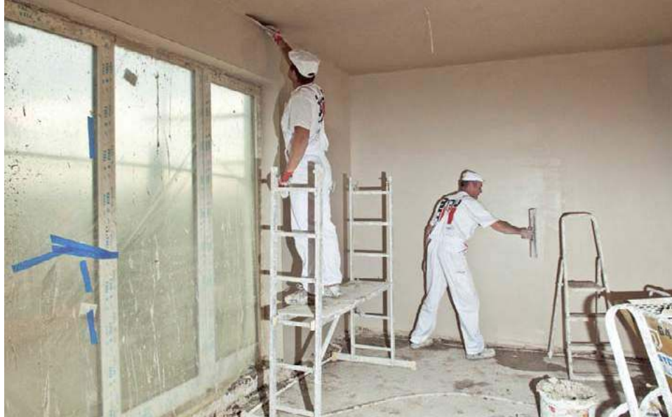
Ściany i sufity tynkuje się po ułożeniu instalacji elektrycznej. BAUMIT
