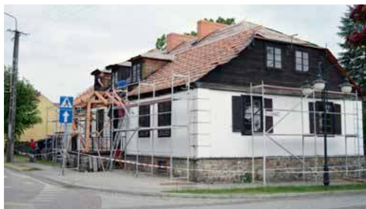
Prace przy przebudowie muzeum w Biezuńcu
