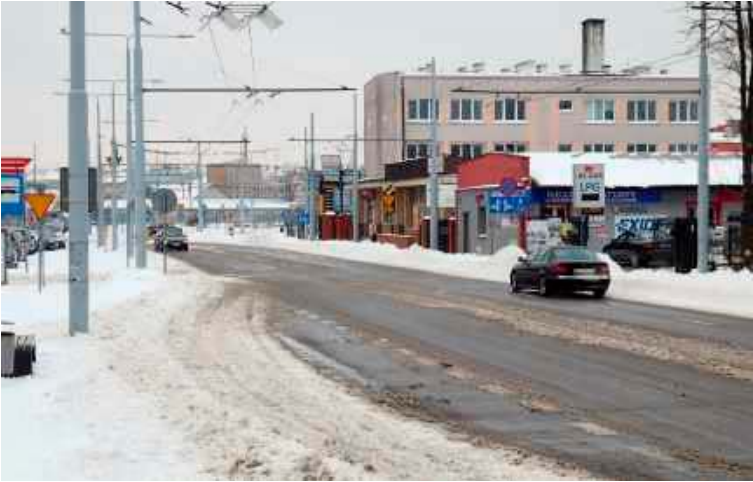
Rozbudowa ulicy Krochmalnej to ostatnie z zadań zleconych przez miasto w związku z budową dworca metropolitalnego i przebudową okolicznej sieci dróg
