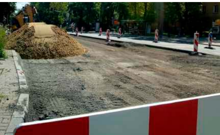
Przebudowa Al. Raclawickich, ul. Lipowej i Poniatowskiego to największa inwestycja drogowa w Lublinie w ubiegłym roku. Jej zakończenie zaplanowane jest na czerwiec br., a całość ma kosztować 103,9 mln zł
