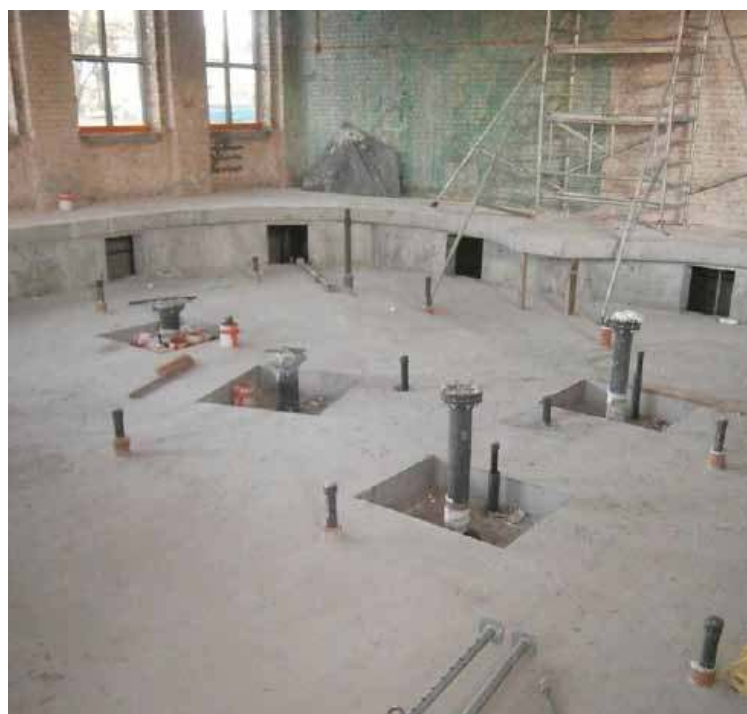
Niecka basenu sportowego została uzbrojona
