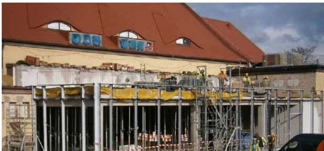
Na pływalni praca wre
