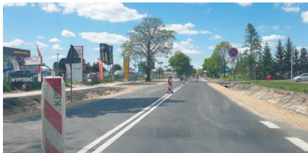
Odcinek ulicy Piaseckiej między Świdnikiem a Lublinem został właśnie przebudowany, a niebawem zyska również oświetlenie
