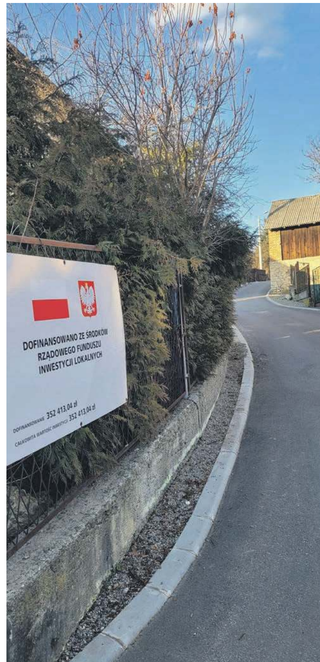
Kasztanowa w Czyżówce ma nową nawierzchnię, ale odwodnienia zrobić się nie dało. Woda z tej stromej uliczki splywa na ul. Długą i posesje położone naprzeciwko
