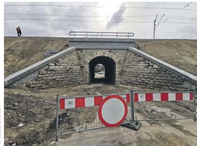
Wiadukt na ul. Krasickiego w Chrzanowie
