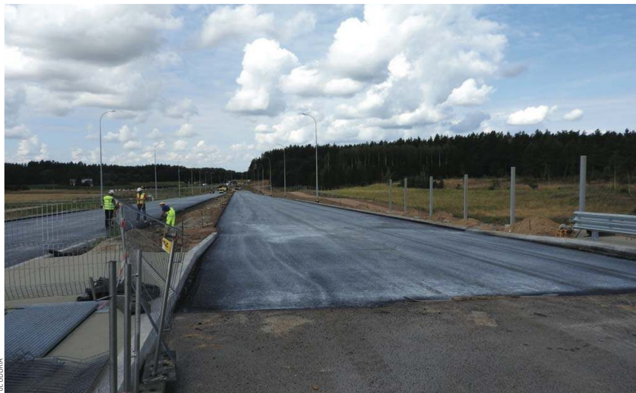
Odcinek S5 Ornowo-Wirwajdy ma być udostępniony kierowcom pod koniec tego roku
