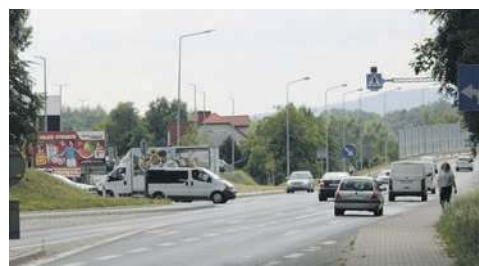
W rejonie skrzyżowania z ul. Krasową na drodze krajowej 79 ma szansę powstać rondo
