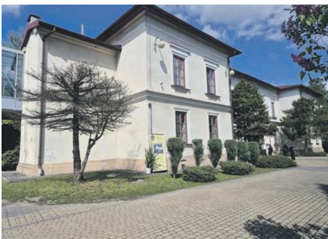
Dach budynku LO czeka remont
