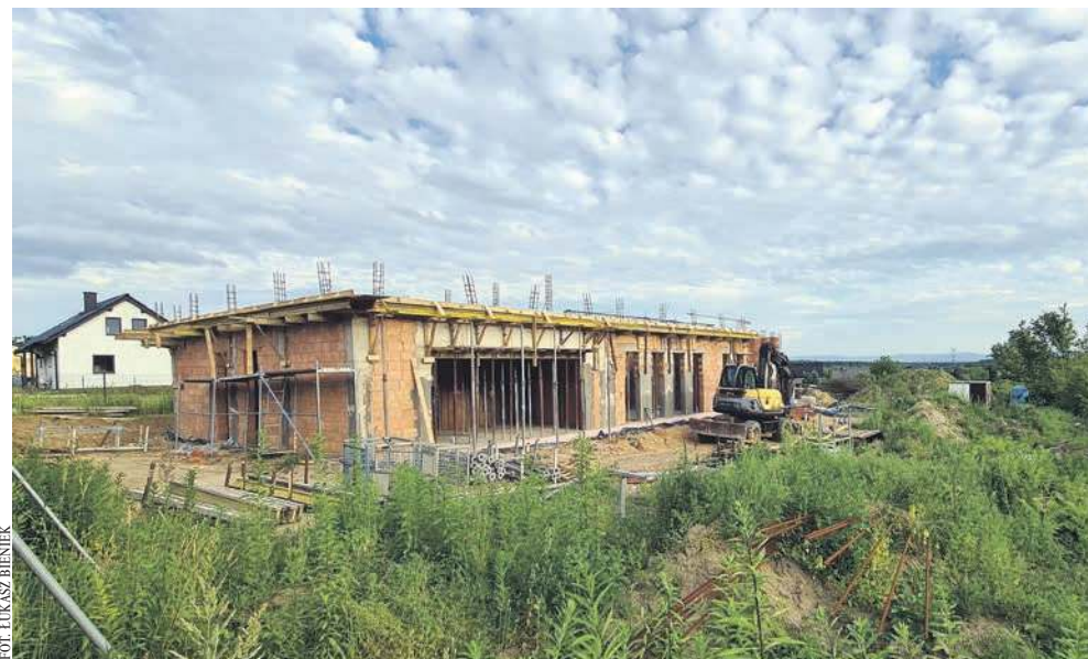
Trwa budowa nowego ośrodka zdrowia w Zagórze
