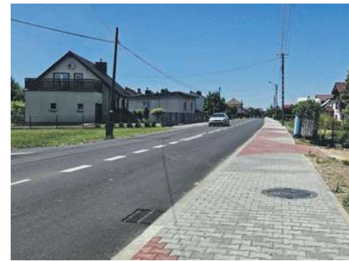
Ul. Nadwiślańska w Gromcu jest już po remoncie
