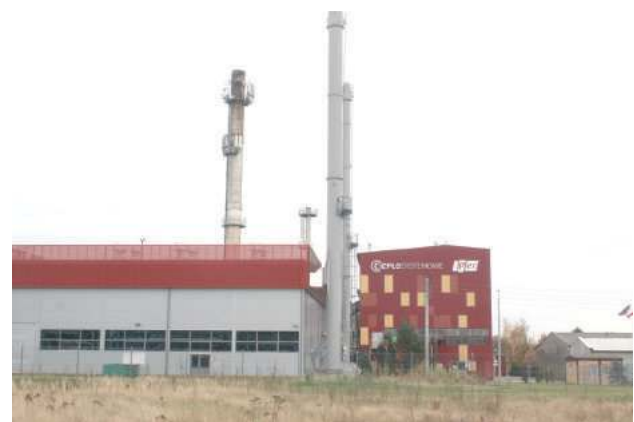
Nowy budynek ciepłowni na biomasę już się trochę zestarzał...
