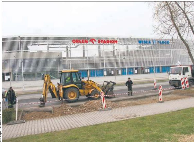
Na ul. 7 Czerwca 1991 r. powstaje nowe przejście dla pieszych
