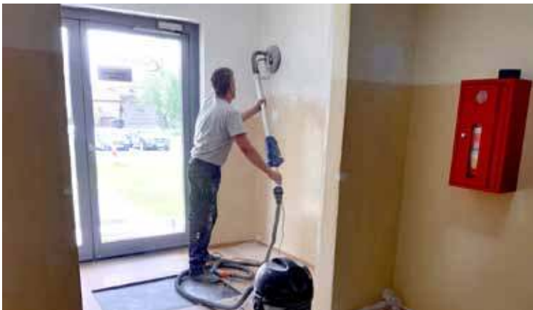
W hali OSiR trwają prace remontowe. Nowy wygląd zyska jeden z korytarzy
