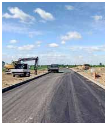
Droga łącząca ulicę Powstańców Warszawy z ulicą Broniewskiego nabiera kształtu. Położono już pierwszą warstwę bitumiczną
