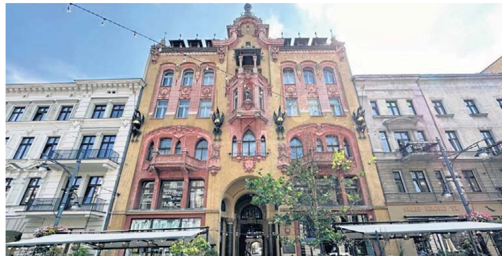
Kamienica pod Gutenbergiem jest objęta ochroną Wojewódzkiego Konserwatora Zabytków, dlatego jej remont wymaga uzgodnień i dużych nakładów finansowych
