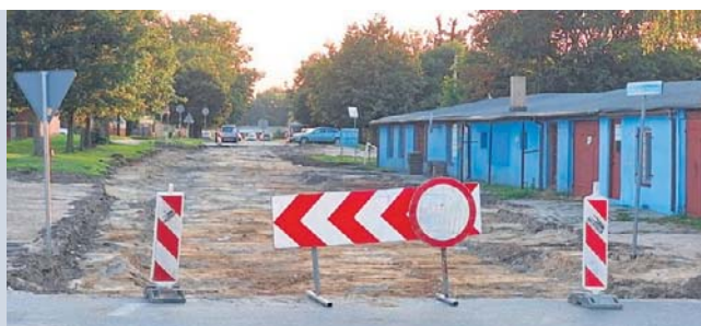
Trwa remont ul. Popiełuszki w Łęczycy
